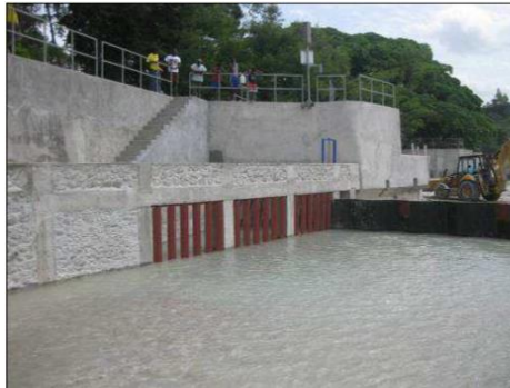
Réhabilitation de l'ouvrage de prise sur berge gauche du système Avezac dans la commune de Camp-Perrin
