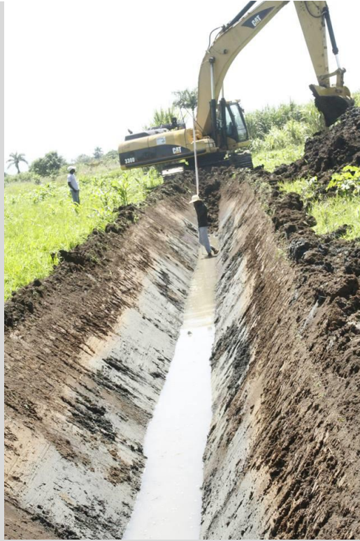
Photo 1 : Construction d'un canal d'irrigation dans le Nord-Est
