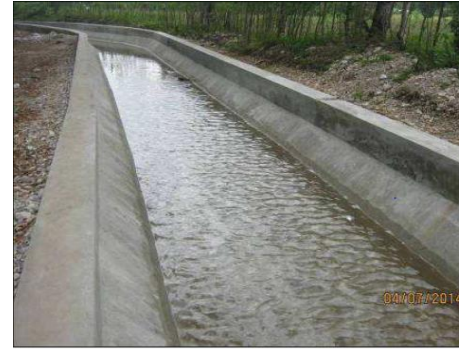
Canal primaire réhabilité à Pesmerle
