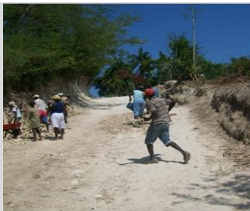
Photo 3 : Réhabilitation du tronçon de route Mouline-Perrier / Corail, Grand'Anse
