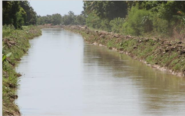
Photo 2 : Canal d'irrigation entièrement réhabilité et remis en état
