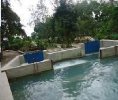
Bassin de distribution mère réhabilité
