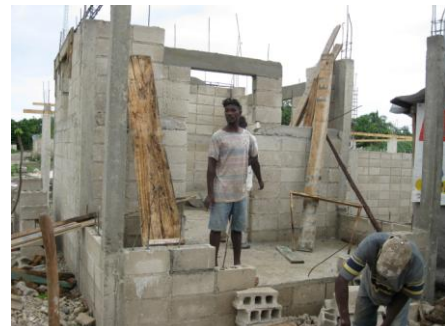
Kindergarten Belle Fleur en construction
