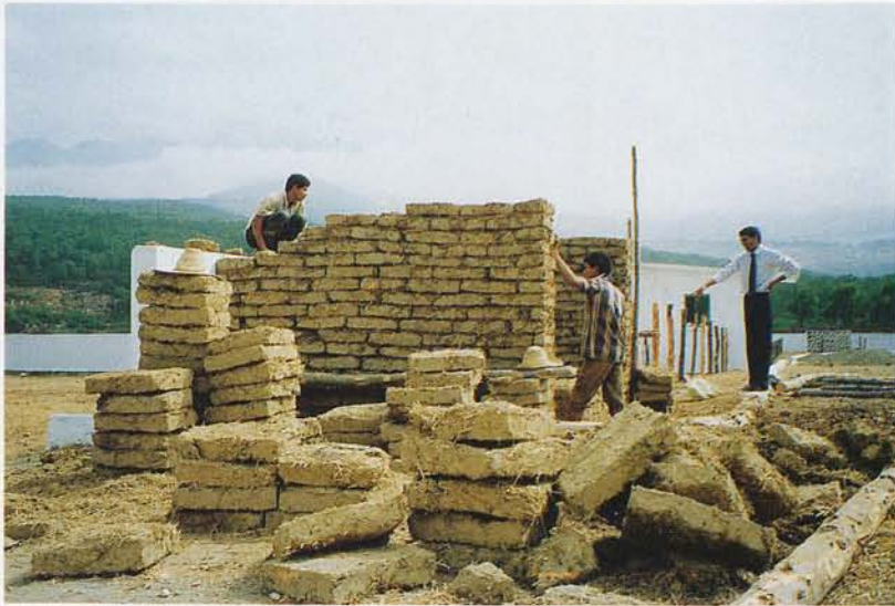
MAROC : construction d'un bâtiment en "adobe" (démonstration pour la foire de Chefchaouen)
